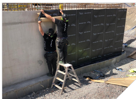
Billederne viser montage af HyDra® Sam 1,5 Wall
